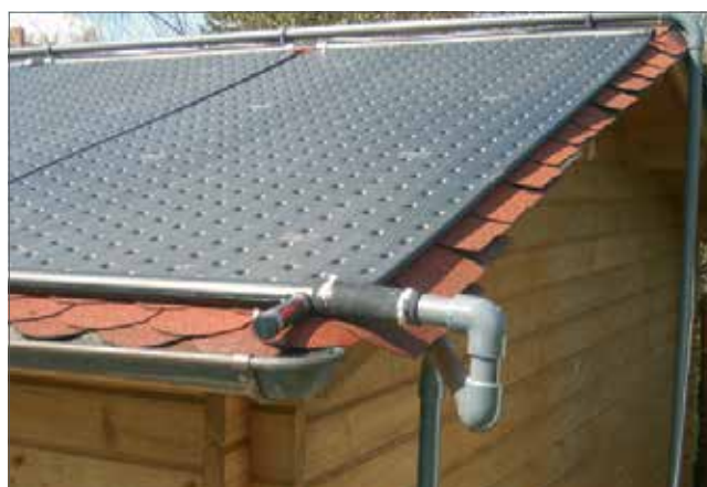
Hellend dak montage
